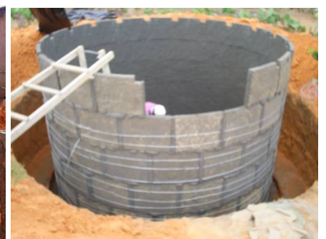
Bau der Zisternen für Regenwasser, in Malhada de Pedras
